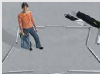
Die markierten Rahmenelemente werden aufgelegt und schnell zusammengefügt.
